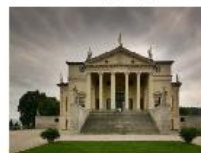
конструкция и пространство
